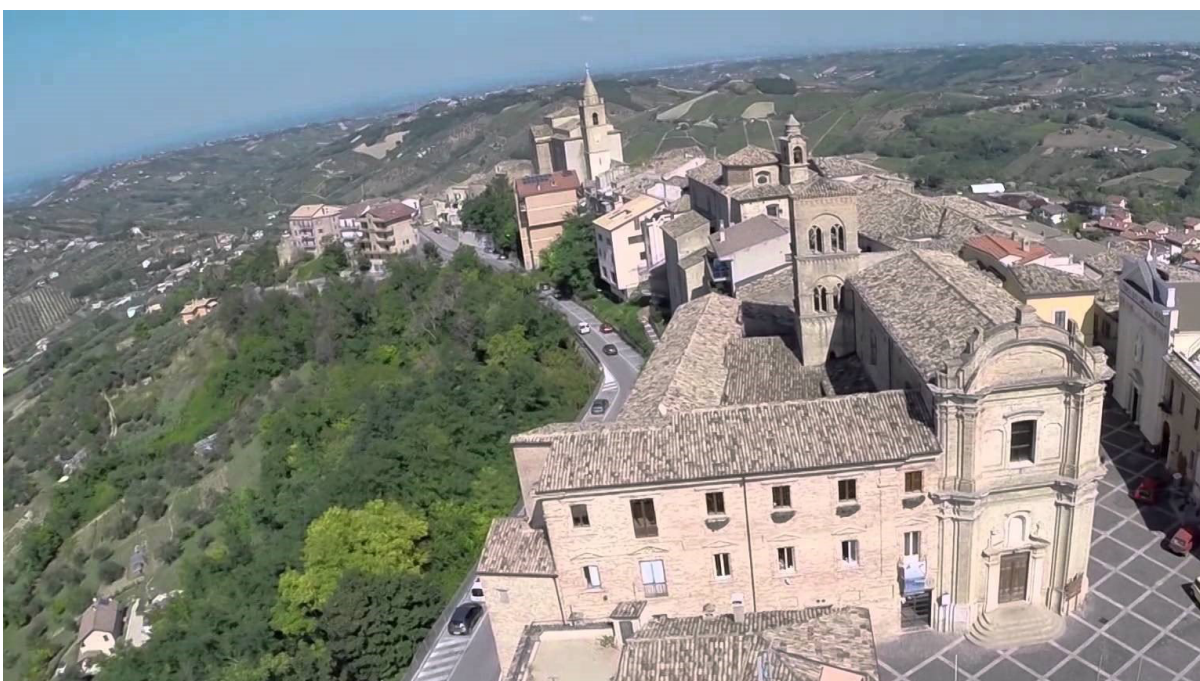
Vista aerea del Centro storico di Bucchianico (il complesso dell'antico convento e della Chiesa di San Francesco e parte della Piazza San Camillo De Lellis (Fonte: periodico on line La Torre).
